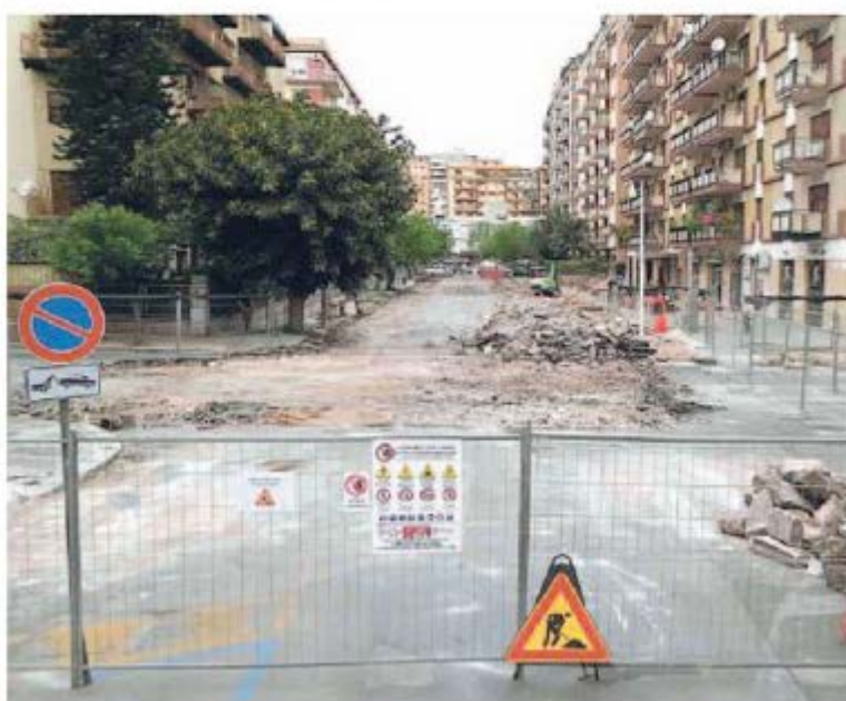
In alto i lavori dell'anello ferroviario, sopra il cantiere del "Passante" in Viale Lazio
